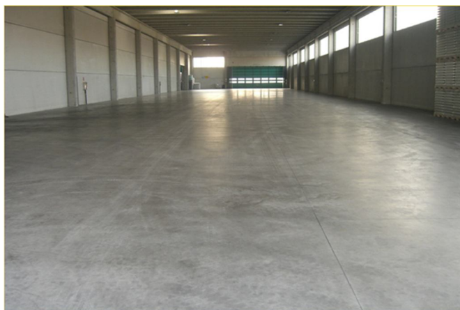
یک سالن با کاربری احتمالی انبار بعد از انجام کف‌سازی سیمانی.
