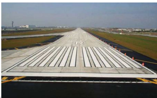
ساخت باند فرودگاه با بتن الیافی
