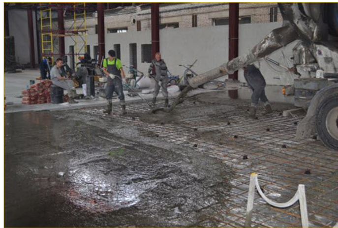
در تصویر بالا عملیات بتن ریزی کف یک سالن را مشاهده مینمایید.
