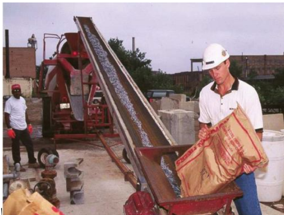
افزودن الیاف به کامیون حمل بتن
