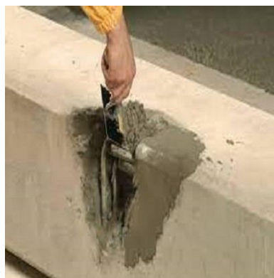
ترمیم بتن با ترکیبات ژل میکروسیلیس
