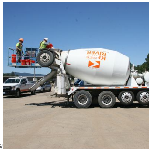
افزودن فوق روان کننده به تراک میکسر
