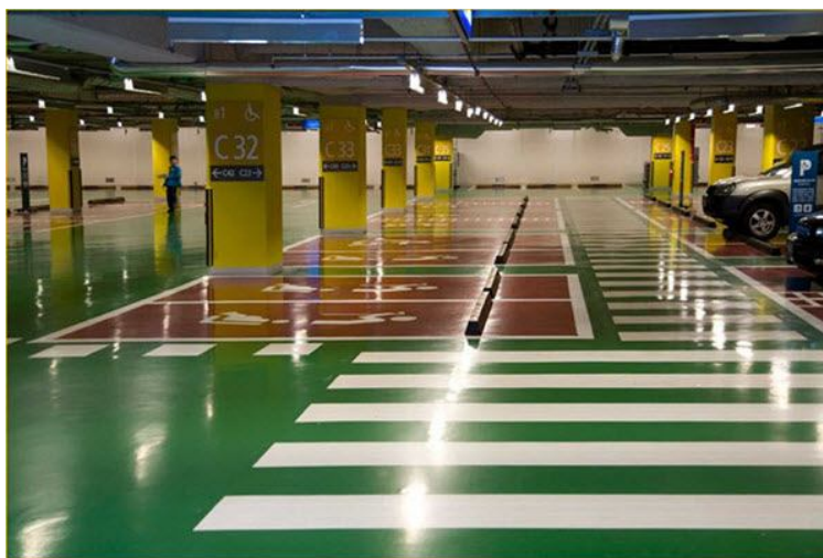
اجرای کفپوش اپوکسی برای کف پارکینگ
