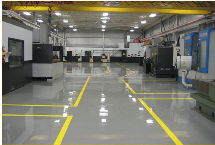
اجرای کفپوش اپوکسی در محیط صنعتی.
