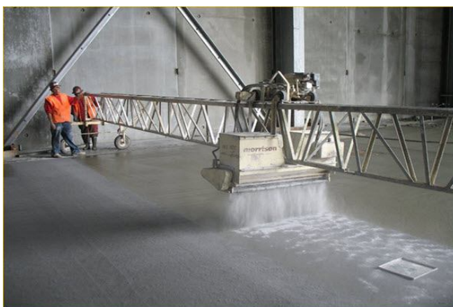
افزودن یکنواخت پودر سخت کننده سطح بتن بر روی بتن تازه.
