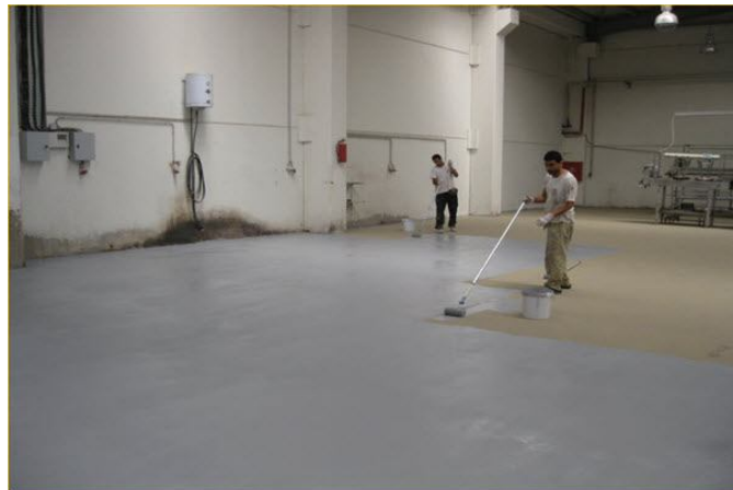
نمونه اجرای کفپوش اپوکسی در محوطه کارگاهی.
